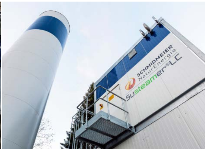
Klimaschutzzentrale mit Kessel.
