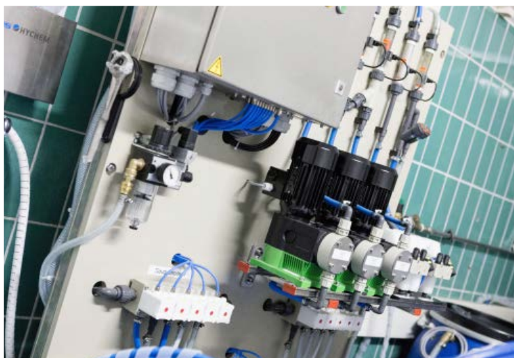
Dosiertechnik als Einschlauchlösung.
